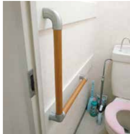
トイレの手すり L型手すりでは立ち座りのサポートをします。下地がない場合は補強板を使用します。
