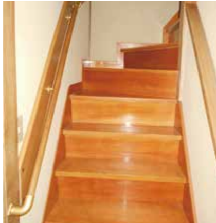
階段の手すり 柱がない場所でも補強板を使って、手すりを取付することができます。
