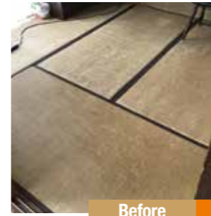
畳 → フローリング デコボコがなくフラットなフローリングに変えることにより、車いすでの移動が容易になりました。
