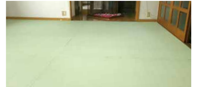
畳 → 畳 滑りにくく、クッション性のある畳へ変更もできます。耐摩耗性があるので車いすの利用も可能です。汚れにも強く、耐久性もあります。
