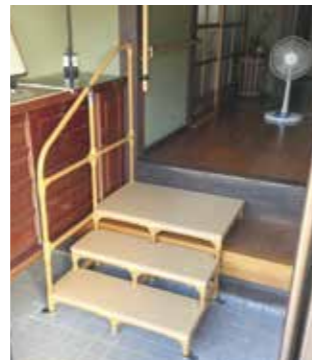
手すり付階段 外出しやすいように手すり付階段を設置しました。
